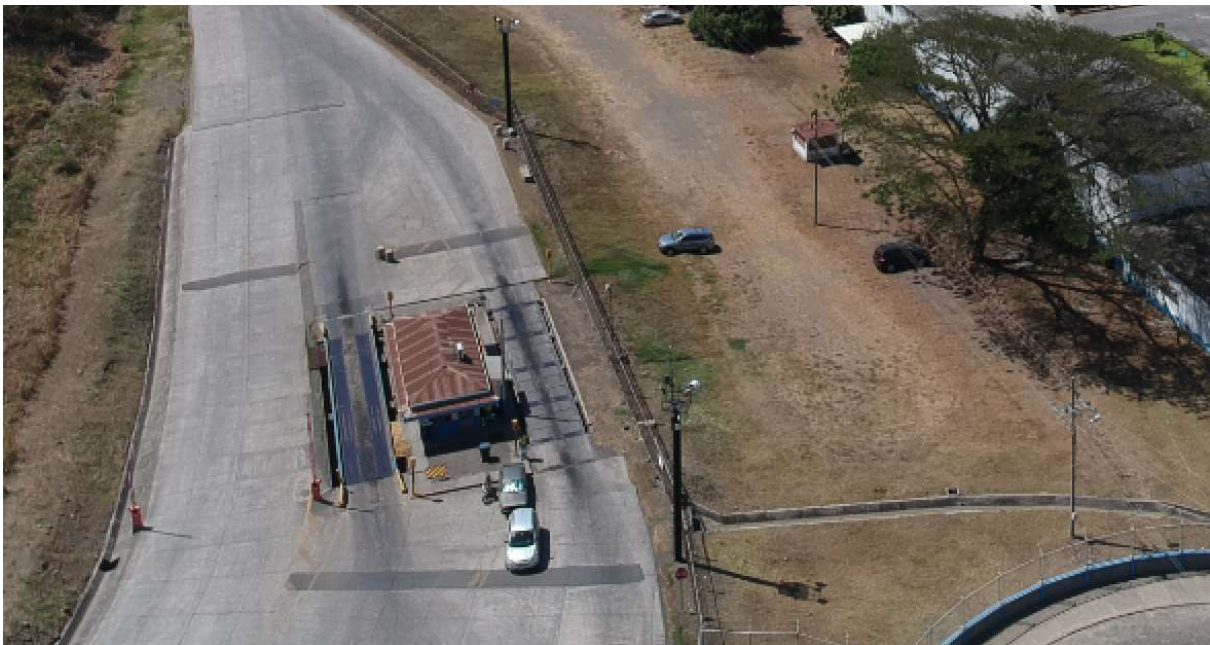
Figura 2-19 Estación de pesaje con una báscula por sentido
